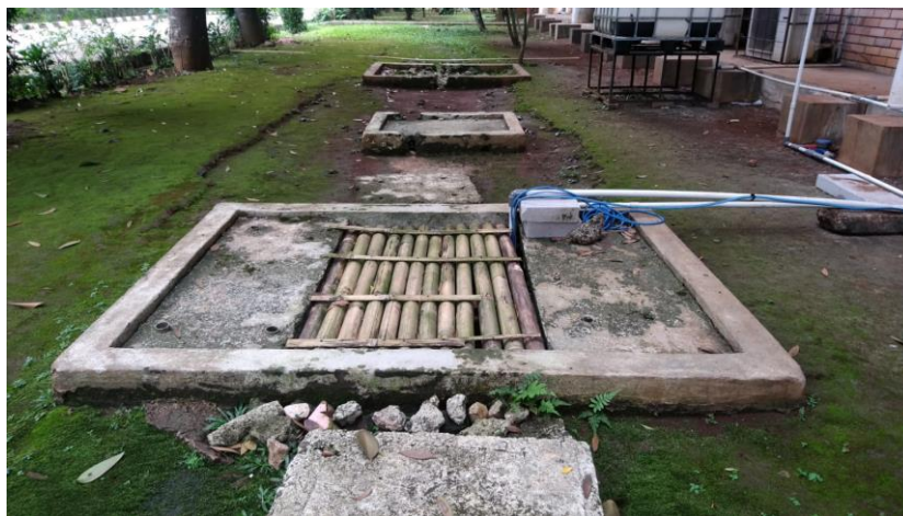
Gambar 3. 5. 4 Pengolahan Penampungan Air Hujan di Filter menjadi Air Bersih
