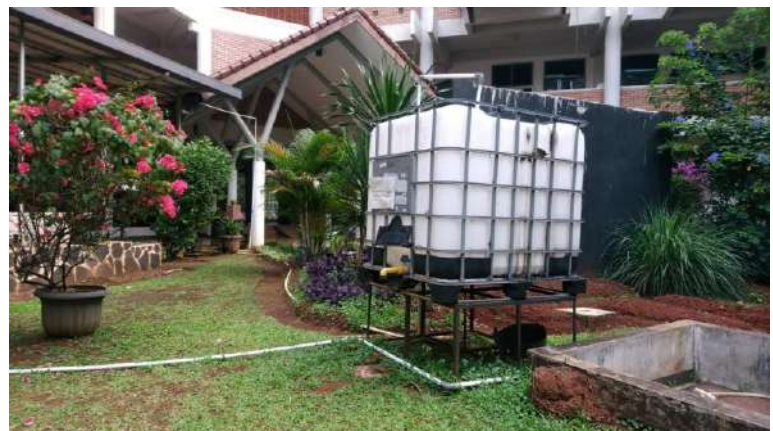
Penampungan air kondensasi AC
