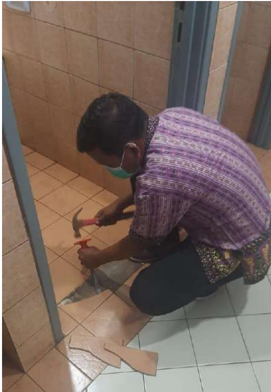
Perbaikan lantai Toilet Gedung
