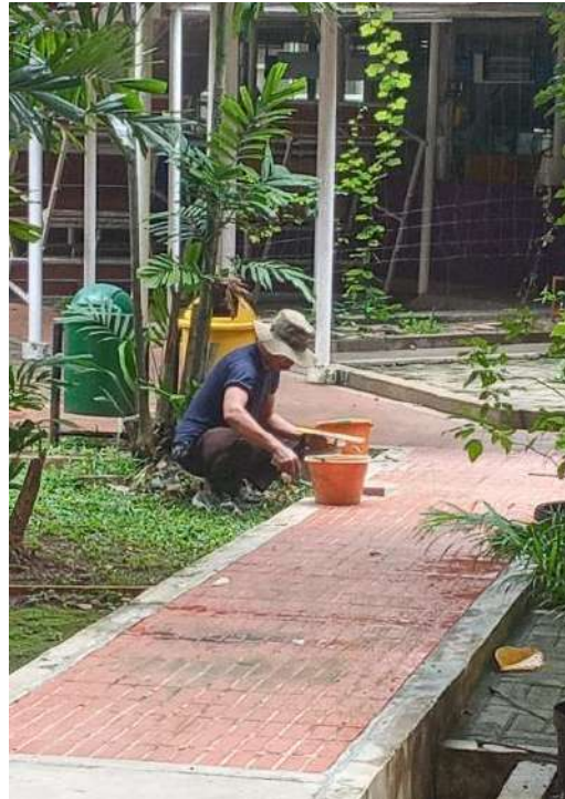
Perbaikan Jalan Setapak Gedung
