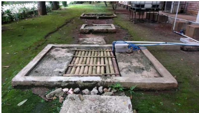
Gambar 2 Pengolahan penampungan air hujan di filter menjadi air bersih
