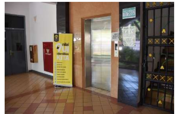
Lift (gedung G)
