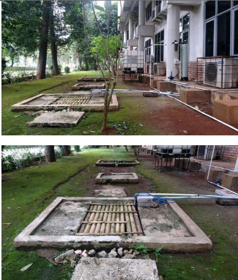
Pengolahan penampungan air hujan di filter menjadi air bersih
