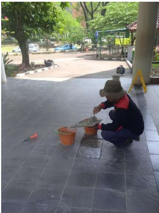
Pemeliharaan dan Perbaikan lantai Lobby Gedung A
