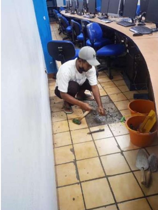
Perbaikan lantai Ruang Lab Komputer/IT Gedung A
