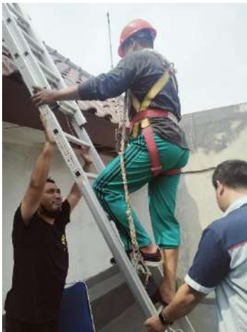
Pemeliharaan Gedung (Perbaikan Atap Bocor Gedung G)
