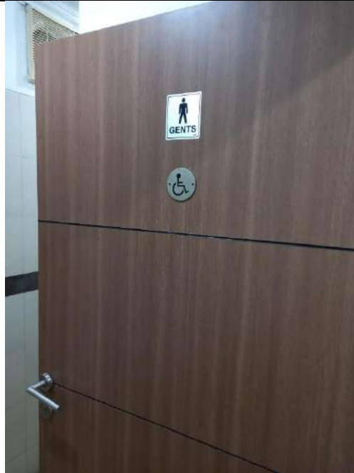
Toilet khusus disabilitas di Gedung B dan Gedung G (di dekat Ruang Guru Besar)
