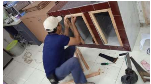
Pemeliharaan Gedung (Perbaikan Wastafel Departemen AKK, Gedung F)
