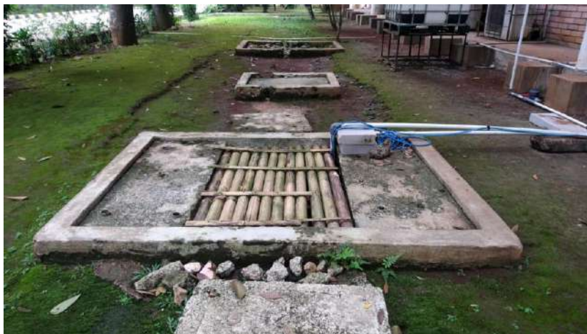
Pengolahan penampungan air hujan di filter menjadi air bersih
