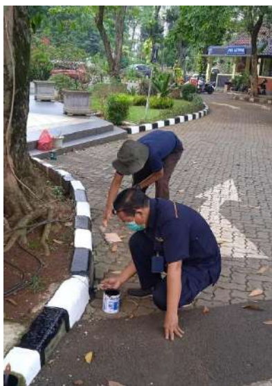
Pemeliharaan Sarana dan Gedung (Pengecatan area Gedung A)
