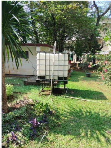
Penampungan limbah air kondensasi AC
