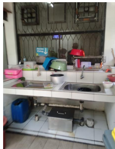
Grease Trap Control di tempat cuci piring Kantin Matoa FKM UI
