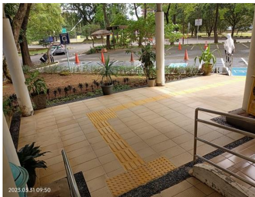
Jalur rambat guiding block dan jalur kursi roda
