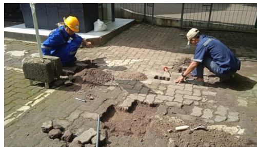
Perbaikan conblock parkir motor
