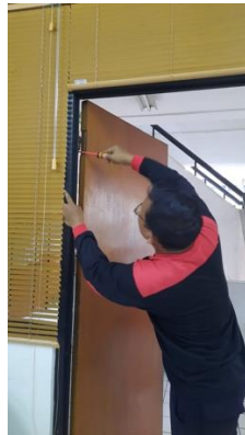
Perbaikan pintu ruangan
