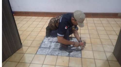
Perbaikan lantai di ruang rapat Gedung B
