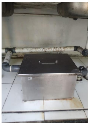
Grease Trap Control di tempat cuci piring Kantin Matoa FKM UI
