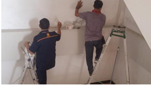
Pengecatan Lobby Gedung A
