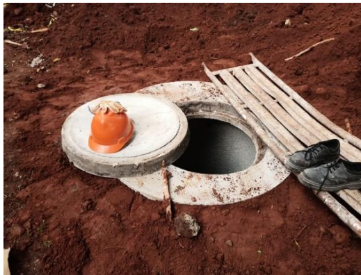
Sumur resapan air
