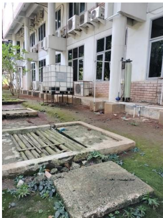
Penampungan limbah air kondensasi AC
