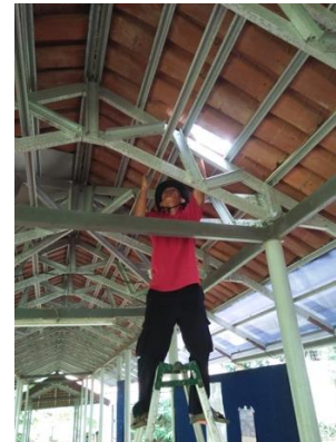
Perbaikan atap di sepanjang selasar
