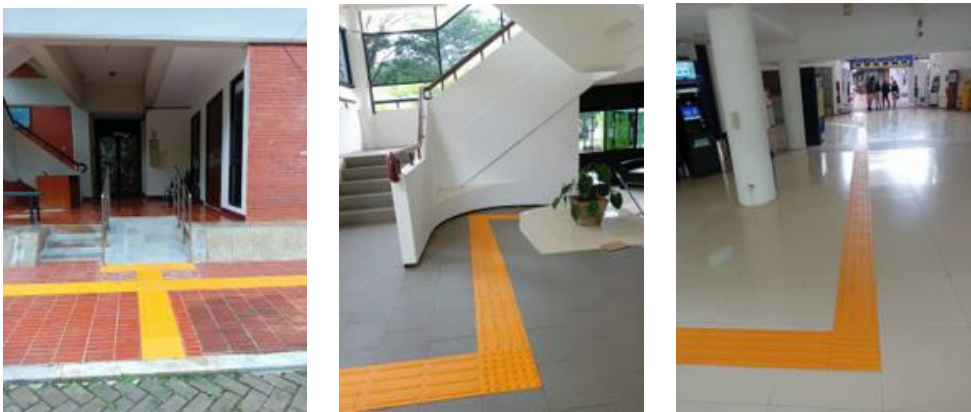
Gambar 3. 37 Jalur pemandu (guiding block) menuju akses loket akademik dan ruang kesehatan Gedung A.
