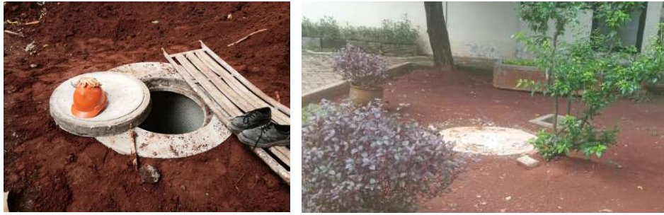
Sumur Resapan Air
