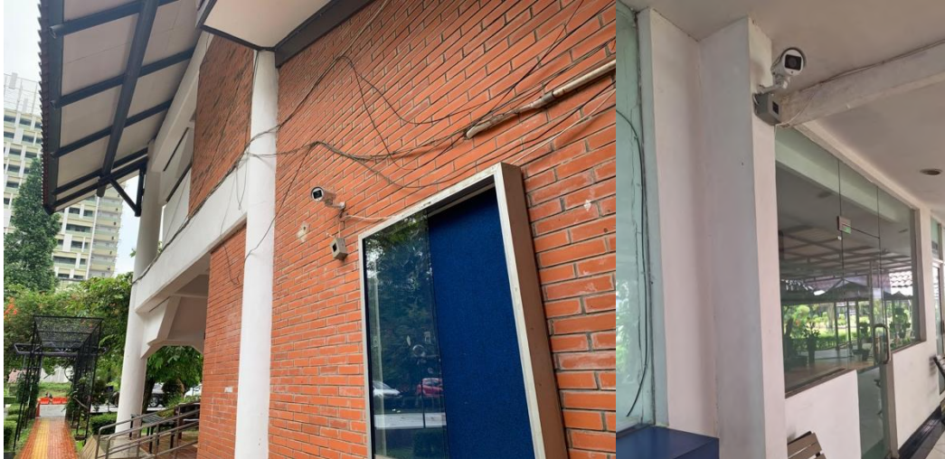
CCTV yang tersebar di setiap Gedung dan lantai
