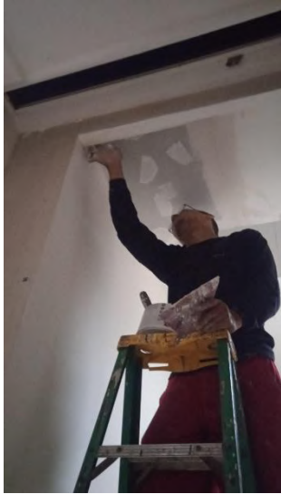
Pemeliharaan dan Perbaikan Fasilitas Gedung B
