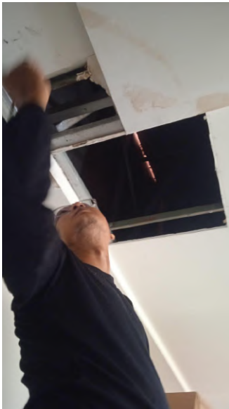
Pemeliharaan dan Perbaikan Fasilitas Gedung F
