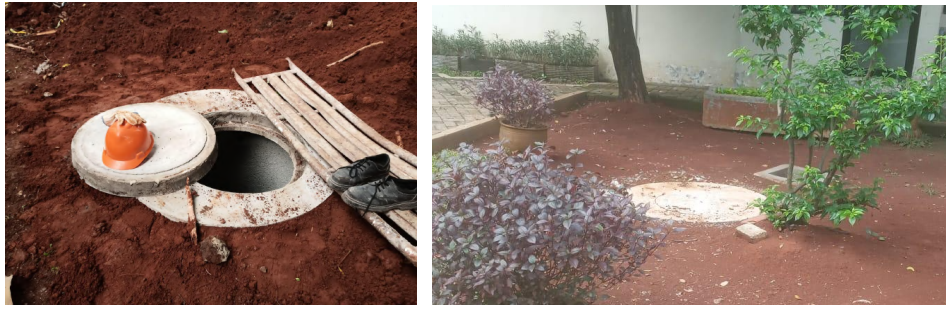
Sumur Resapan Air
