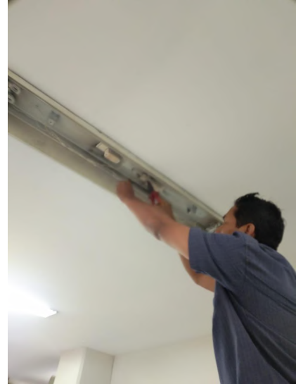
Pemeliharaan dan Perbaikan Fasilitas Gedung C
