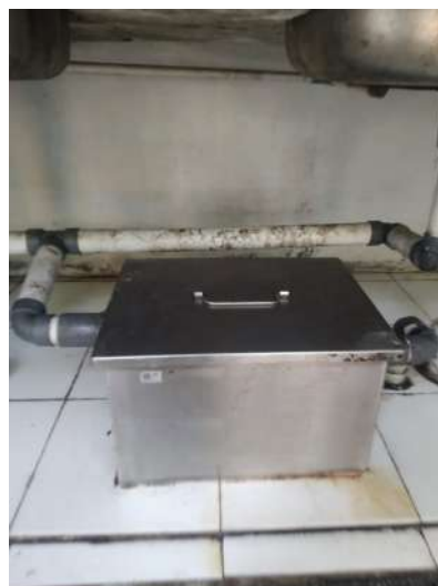
Grease Trap Control di Tempat Cuci piring Kantin Matoa FKM UI
