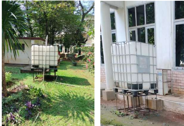
Penampungan Limbah Air Kondensasi AC
