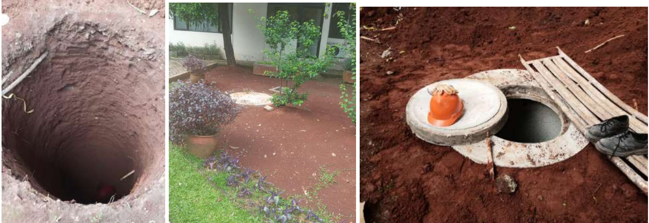
Sumur Resapan di Gedung B FKM UI
