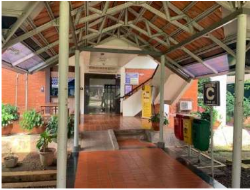
Gedung C FKM UI (Area: 639 m 2 )
