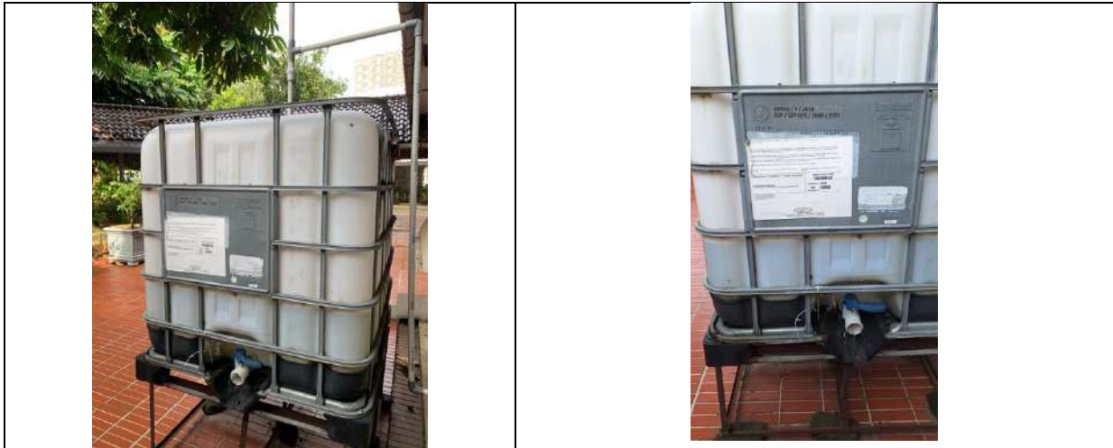
Penampungan limbah air kondensasi AC
