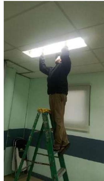
Pemeliharaan dan Perbaikan Fasilitas Gedung G
